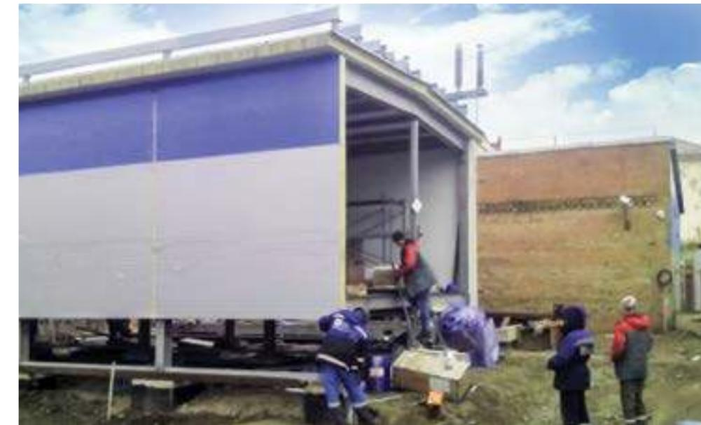
Специалисты ООО «Камаэлектромонтаж» ведут комплексную реконструкцию ПС 110/10 кВ «Молодежная» с заменой трансформаторов 2x25 на 2x40 МВА и реконструкцией ОРУ/ЗРУ. Заказчиком работ выступает ПАО «МРСК Сибири».
